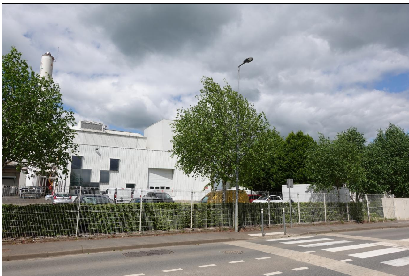
Entreprise Nexira de Serqueux
