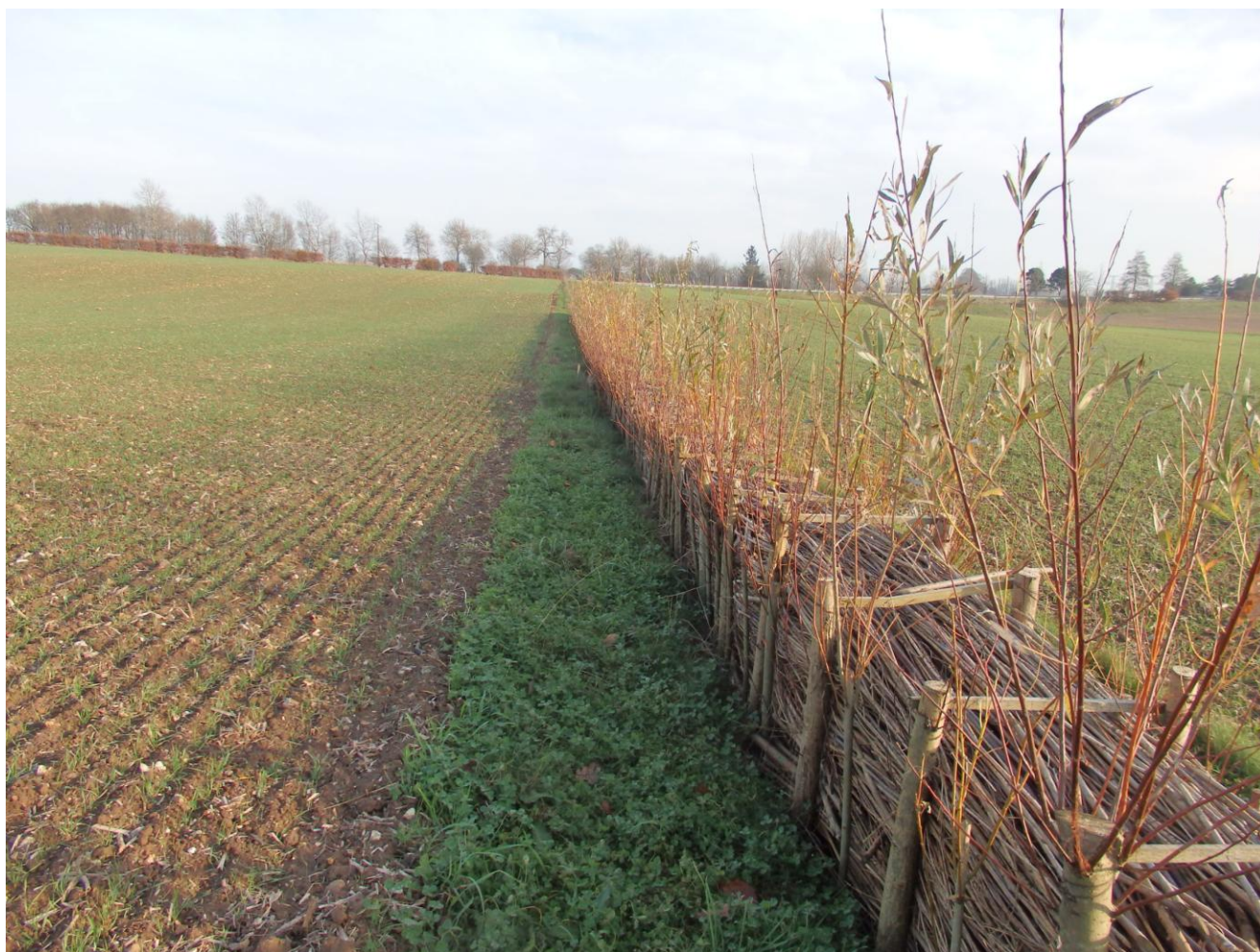
Une fascine réalisée par le Syndicat des Bassins Versants Saône Vienne Scie, en cours de reprise végétale (source SBVSVS)
