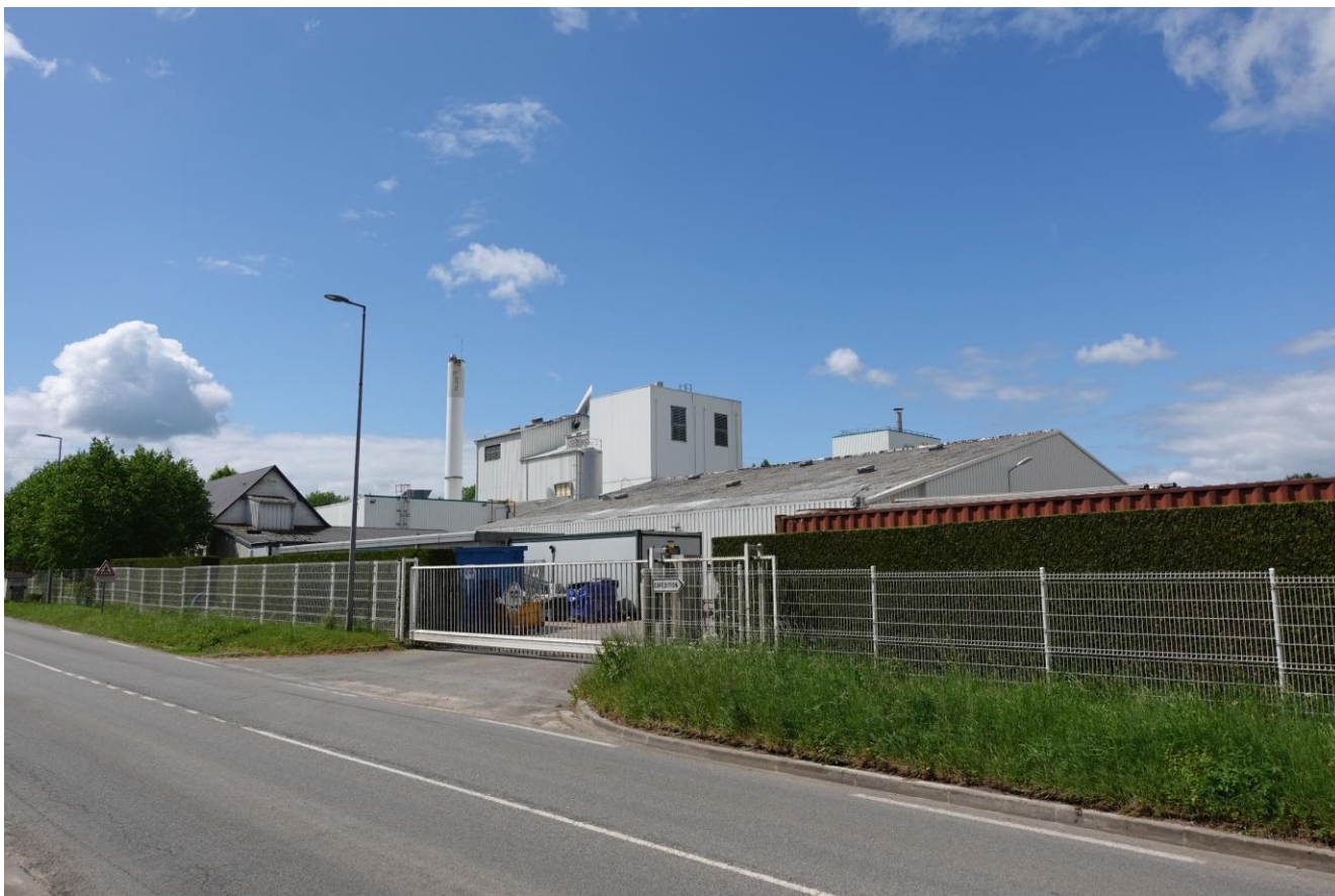
Le site industriel existant
