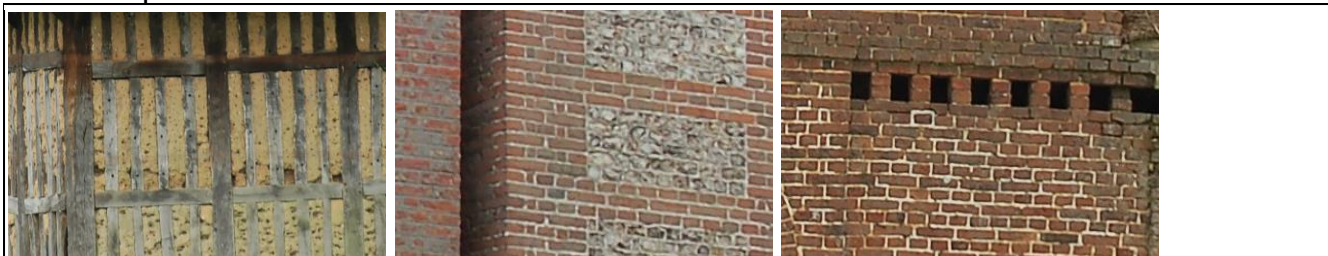
Exemples de matériaux traditionnels locaux (colombage et torchis / brique et silex / brique)
