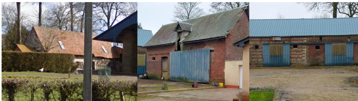
Bâtiment n°6 / Bâtiment n°7 / Bâtiment n°8
